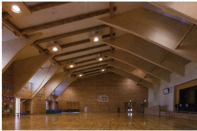
図 1-22 長野県稲荷山養護学校
