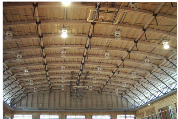
図1-11 長南中学校体育館
