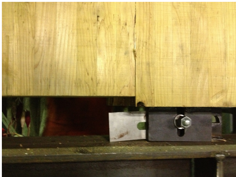
b) 木質パネル脚部のせん断破壊状況
