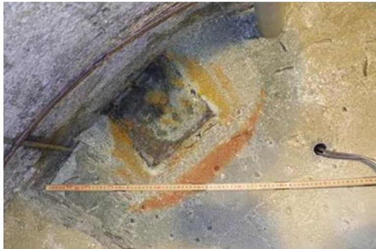
図 7-18 FEBEX 試験で確認されたベントナイト周辺の赤錆発生状況写真 13) (計測用鉄製容器周辺)
